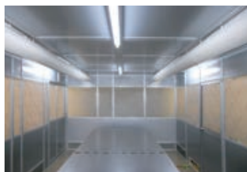
ルーム内吹出口 施行例
